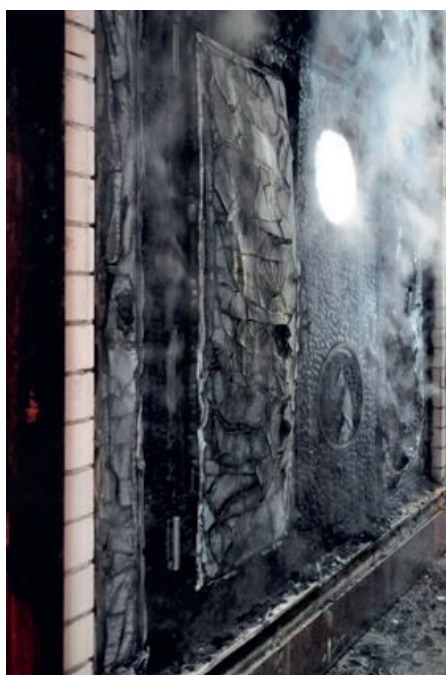
Abb. 2 Brandseite der Tür nach der Brandprüfung
